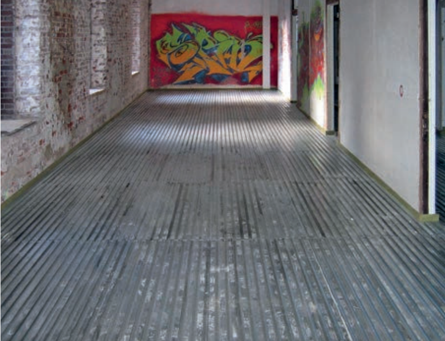
Verlegte LEWIS®-Schwalbenschwanzplatten mit Randdämmstreifen vor dem Vergießen des Betons.
