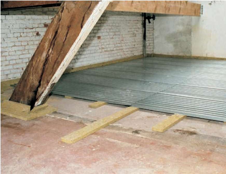
LEWIS®-Schwalbenschwanzplatten verlegt auf mineralischen Luft- und Trittschallstreifen
